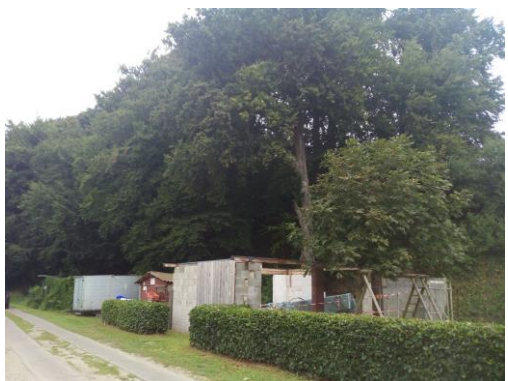
Abbildung 24 Nebengebäude mit Böschung
