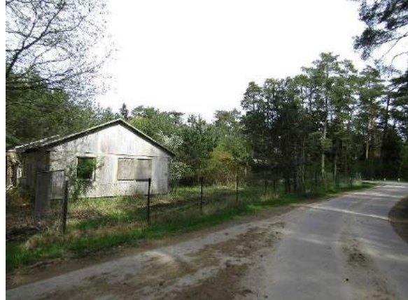
Abbildung 107 ruiniertes Gebäude mit Einfriedung am Campingplatz
