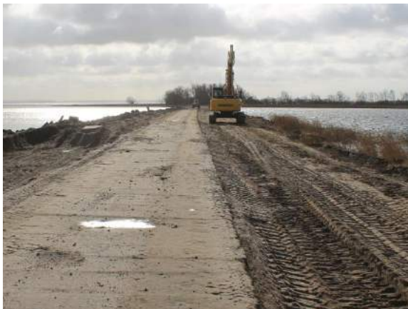
Abbildung 32 Rückbau des Damms zur Insel Görmitz
