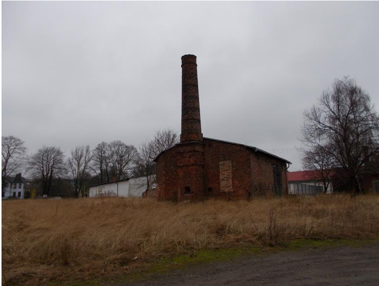
Abbildung 13: verbliebene Industriegebäude auf derzeitiger Brachfläche
