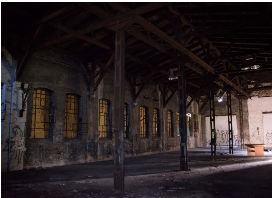
Abbildung 7. Das Innere der größeren Halle ist dunkel, weil die Fenster mit Platten verblendet und die großen Hallentore zugemauert sind, eine isolierende Decke gibt es hier nicht; R. Grunewald.
