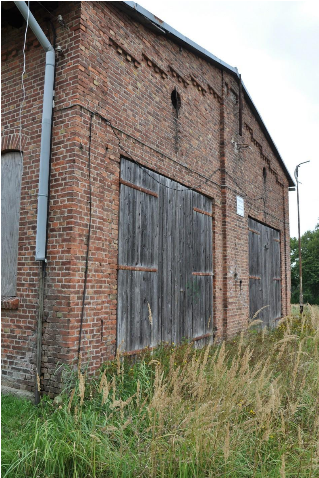
Abbildung 9. Die von innen vermauerten Hallentore, hier die Giebelseite der größeren Halle, bieten im Spalt zwischen Holz und Mauerwerk Raum für Fledermausquartiere; F. Erdmann.
