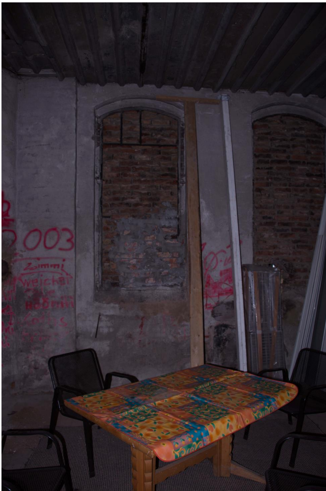
Abbildung 8. In der kleinen Halle gibt es eine Deckenverkleidung (allerdings mit schadhafte Stellen), die eine Mineralwolle-Dämmung trägt, hier sind nicht nur das große Tor, sondern auch die Fenster vermauert; R. Grunewald.
