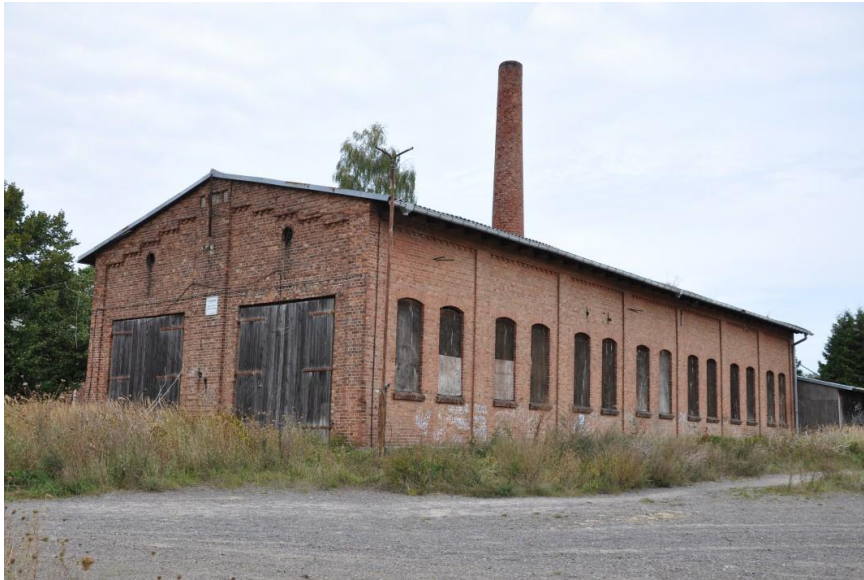
Abbildung 3. Die größere Werkhalle mit dem 20-m-Schornstein, Aufnahme von Süden. Der Schornstein ist auf der Abbildung 4 besser zu erkennen; F. Erdmann.
