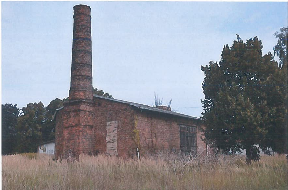
Abbildung 2. Die kleine Werkhalle mit dem 14-m-Schornstein, Aufnahme von Süden. Das Gebäude war ursprünglich länger; am jetzt nordöstlichen Ende des Firsts ist der Stumpf eines anderen Schornsteins zu erkennen; F. Erdmann.
