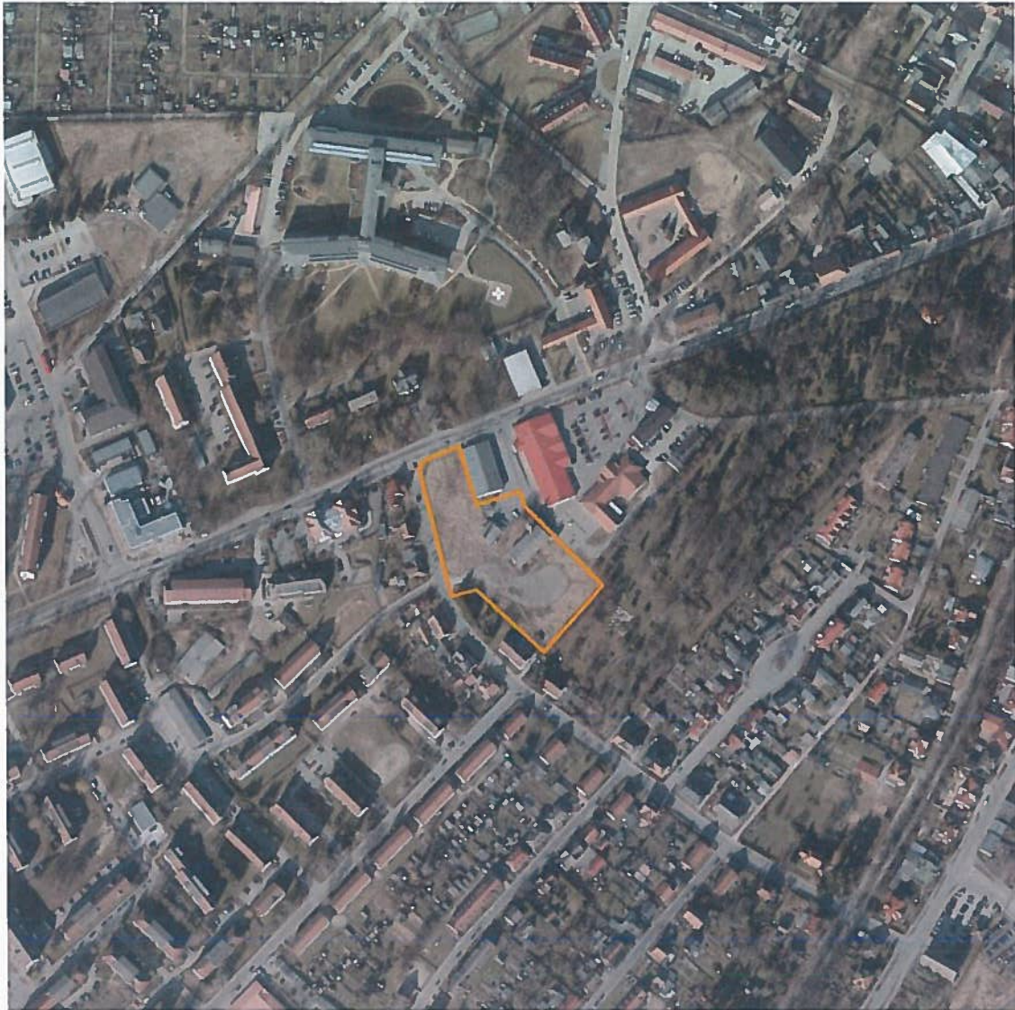
Abbildung 14. Die Umgebung des Objekts ist sowohl von Wohngebieten unterschiedlicher Struktur als auch von Parkanlagen und von Klein- und Hausgärten geprägt; Luftbild LAiV M-V.
