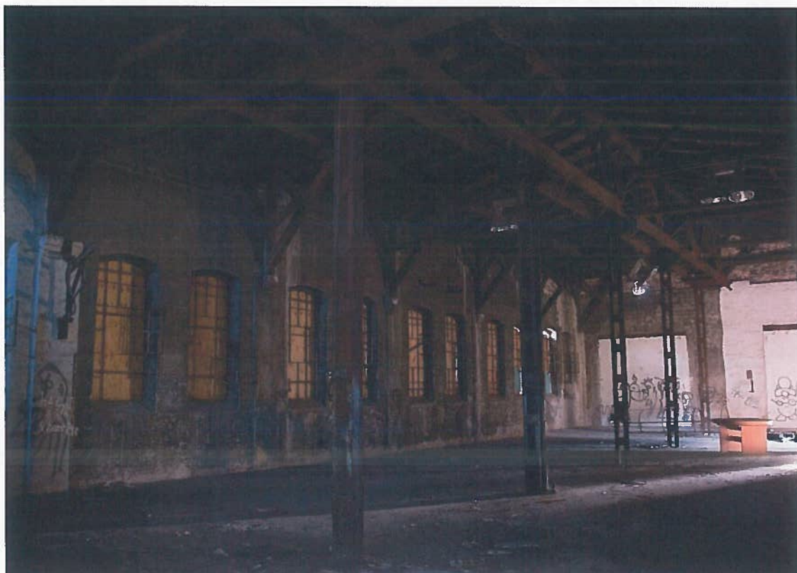
Abbildung 7. Das Innere der größeren Halle ist dunkel, weil die Fenster mit Platten verblendet und die großen Hallentore zugemauert sind, eine isolierende Decke gibt es hier nicht; R. Grunewald.
