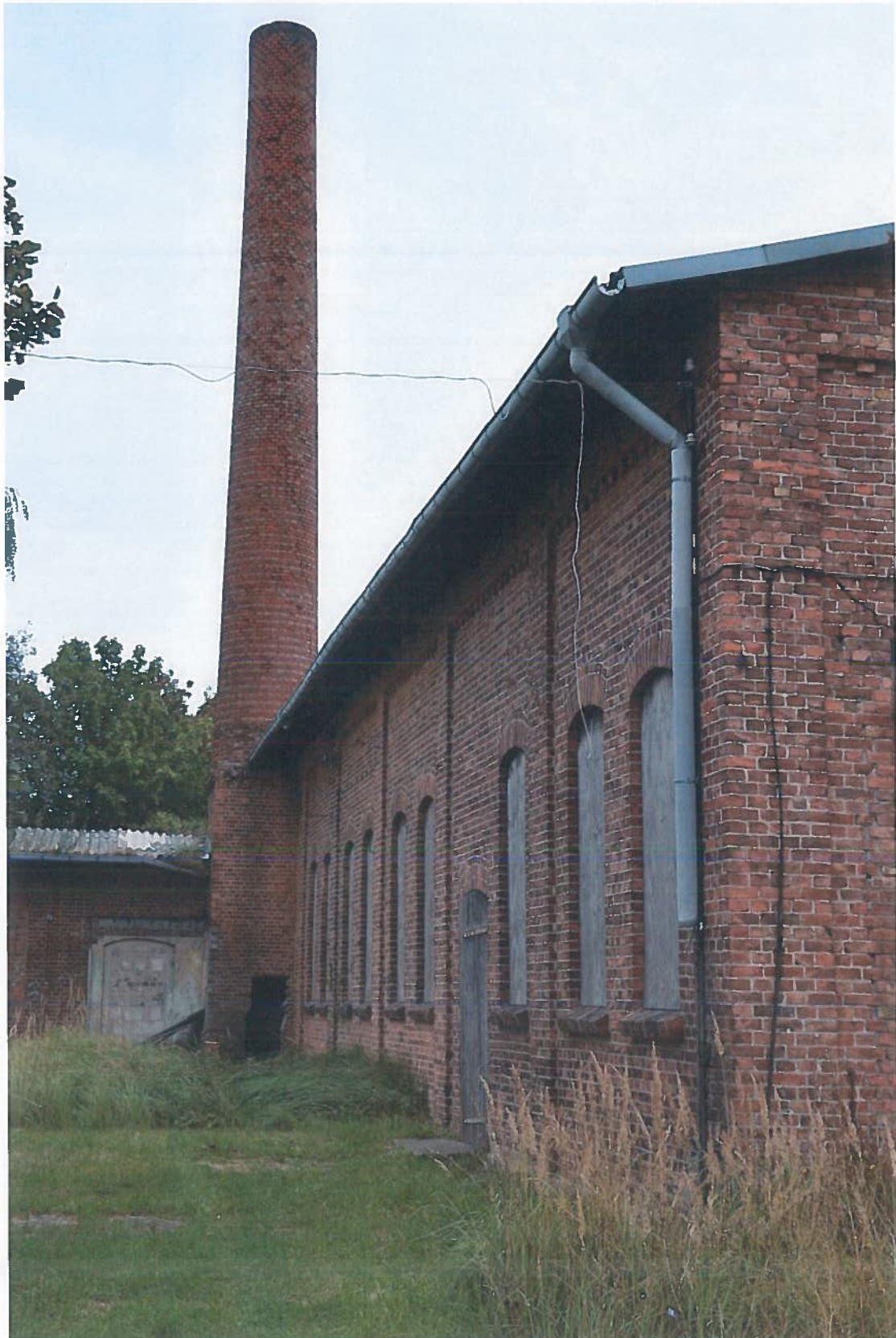
Abbildung 4. Die größere Werkhalle mit dem 20-m-Schornstein, Aufnahme von Westen. Auf dem Schornstein befand sich früher ein Storchenhorst, dessen Reste jetzt den unteren Teil des Kaminschachts füllen. Im Inneren befinden sich Aufstiegshilfen in Form eiserner Bügel, die von Dohlen und Krähen als Schlafplatz genutzt werden; F. Erdmann.
