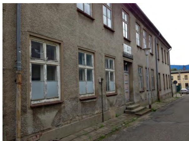
Schützenstraße 8 (ehem. Oberschule)
