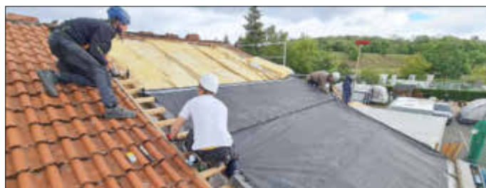
Bauhelfer in Aktion bei der Modernisierung der Dachisolation
