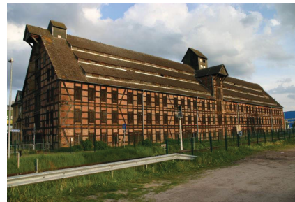
Abbildung 3 Fachwerkspeicher (bzw. Getreidespeicher, oder auch Homeyer-Speicher)
