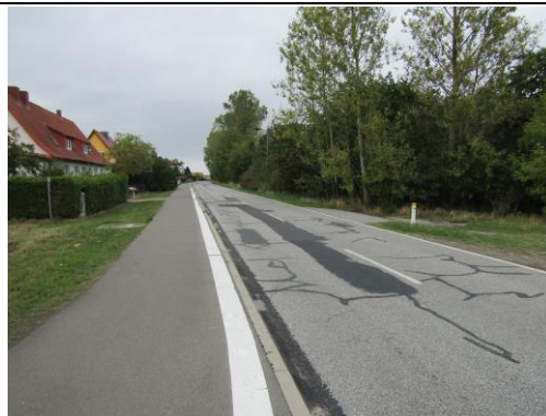
Abbildung 8 aufgebaute Baumhecke entlang des "Lütower Weges"
