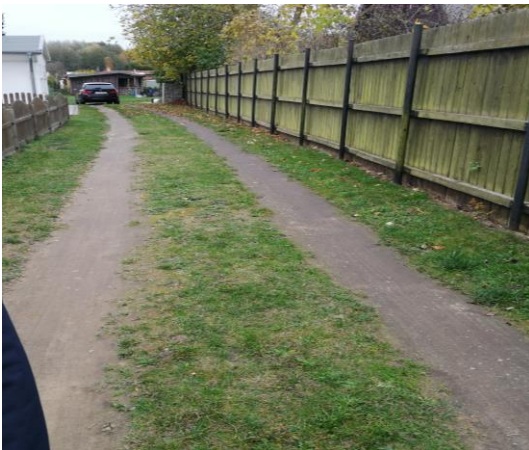
Abbildung 7 unversiegelter, stark verdichteter Weg
