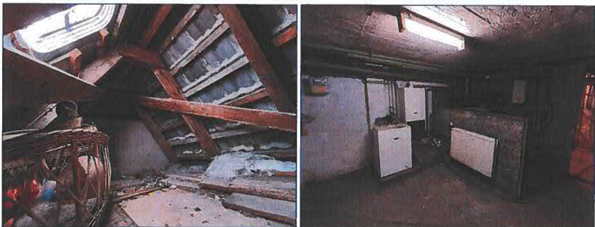
Abb. 4 und 5 Ansichten vom Dachboden und Keller
