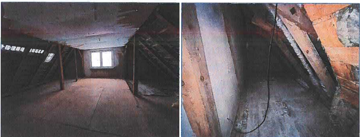
Abb. 6 und 7 Ansichten vom Obergeschoss
