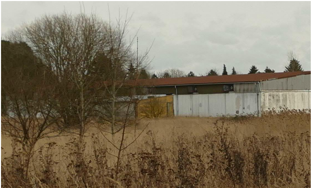
Bild 09: Verschlussener Schuppen (OIG) im Süden des Plangebietes
