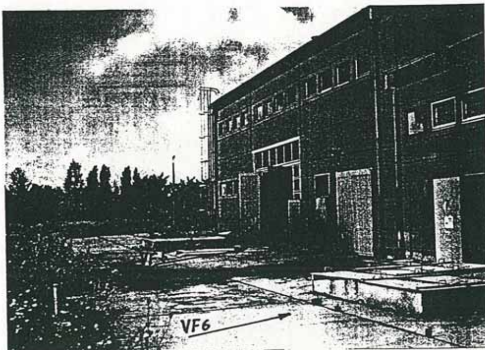
Bild 2: Blick auf VF 5 Farblackiererei und VF 6 Brünierwerkstatt mit den im GW-Abstrom befindlichen GW-Meßstellen 5/93 und 6/93.
