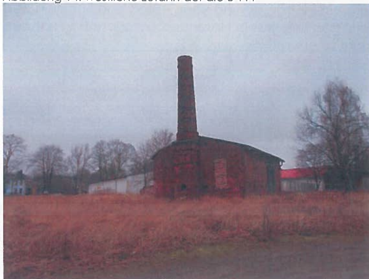
Abbildung 15: verbliebene Industriegebäude auf derzeitiger Brachfläche
