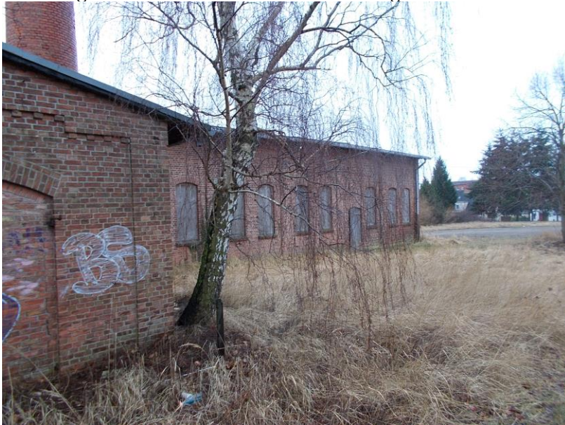
Abbildung 7: Restliche Gebäude auf ehemaliger Industriefläche
