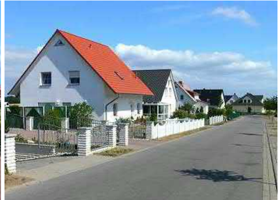
Neue Wohnhäuser, Baujahr nach 1990
