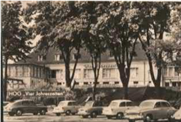
Ehem. Gaststätte „Vier-Jahreszeiten“
