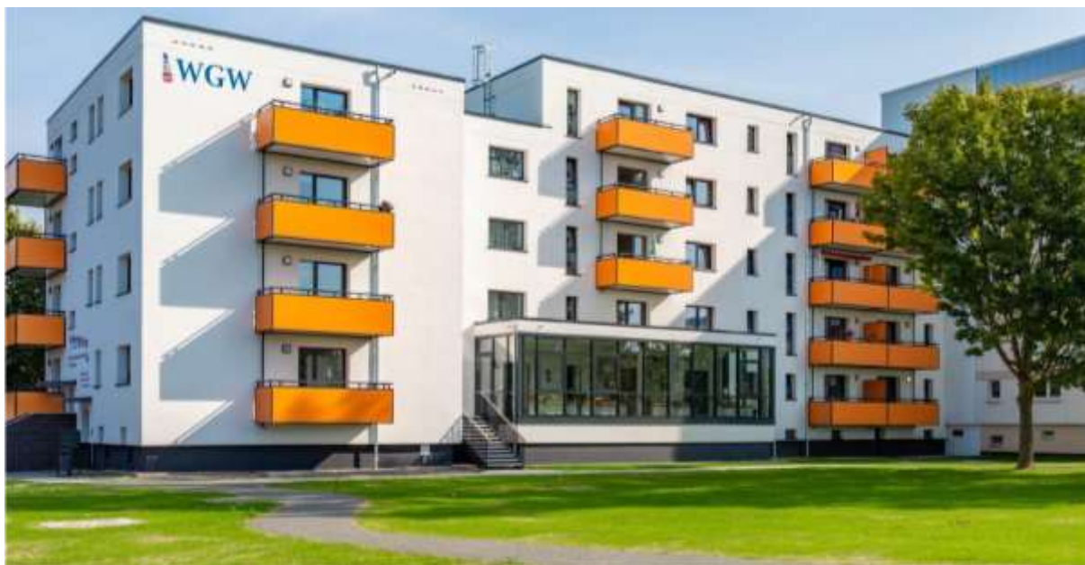
Nach dem Umbau
