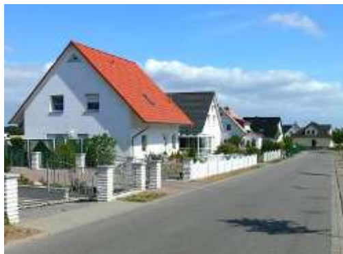
Neue Wohnhäuser, Baujahr nach 1990
